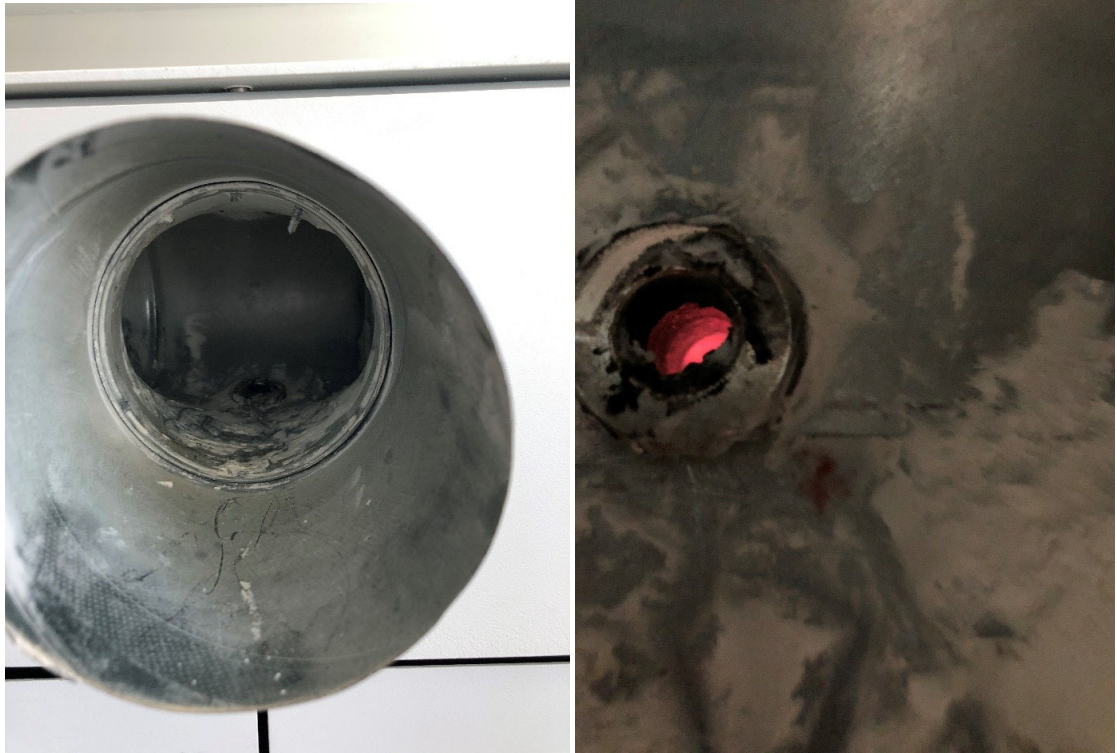
Figure 70 : Sortie après le nettoyage
