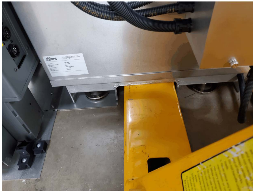
Figure 218 : Levage de la cuve
