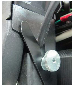
Figure 6-92 : Câble de la lampe UV après remise en place de l'ensemble
